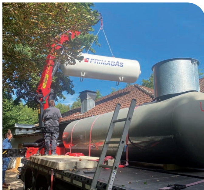
Der Gastank wird über das Gebäude gehoben, um seinen Standort zu erreichen. (Foto: Bernd Armbruster)
